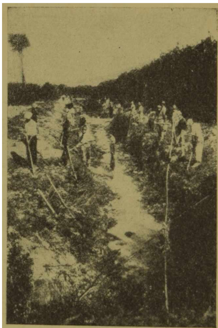
FIG. 43. — CAMPOMALE (RONCOFERRARO, MANTUA) AL EMPEZARSE LAS OBRAS DE SANEAMIENTO. (Foto Calzolari. Mantua).
